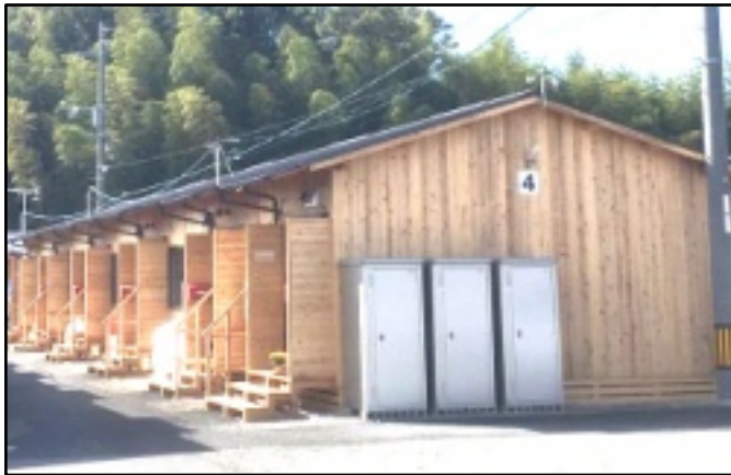
木造の仮設住宅（みその）
